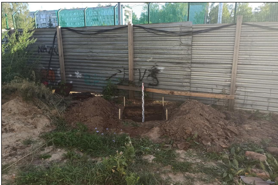
Илл. 13. Г. Кстово. Земельный участок в 3-м микрорайоне. Шурф №1 после зачистки. Общий вид с севера.
